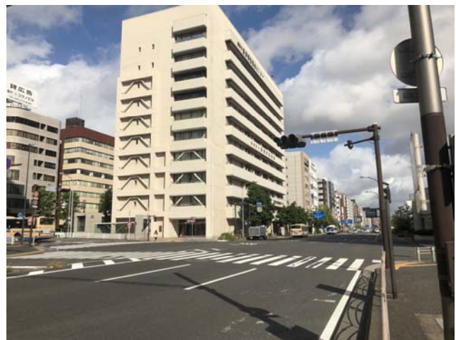
沿道建築物の耐震化の事例
