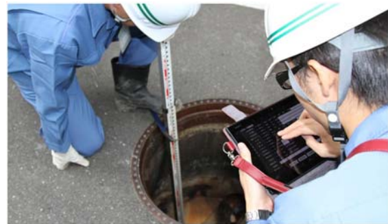
公民連携で開発したシステムを利用した 下水道管実地調査訓練
