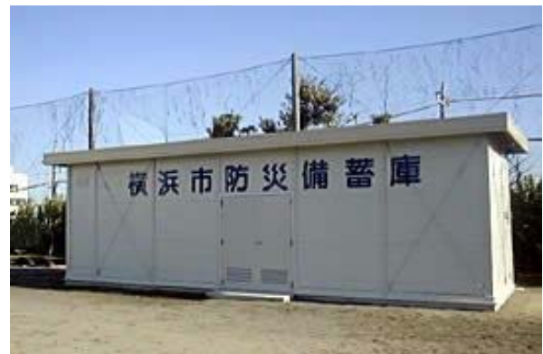
地域防災拠点の防災備蓄庫
