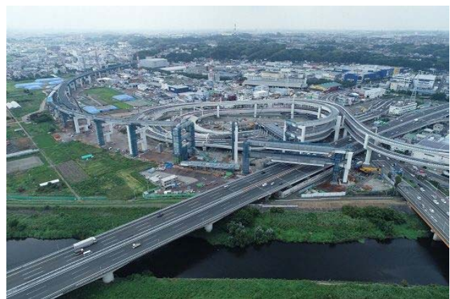
横浜環状北西線（川向地区）
