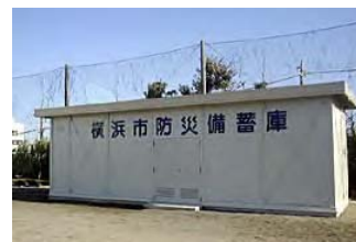
地域防災拠点の防災備蓄庫
