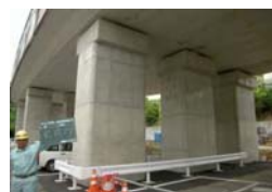
橋梁の耐震化 (谷津坂第一高架橋)
