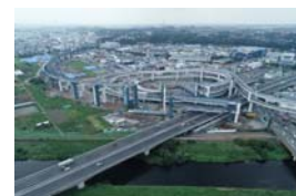
横浜環状北西線（川向地区）
