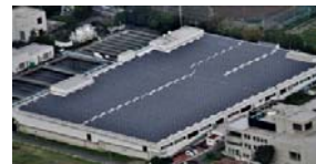
西部水再生センターの メガソーラー
