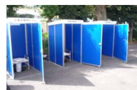
下水直結式仮設トイレ (災害用ハマッコトイレ)
