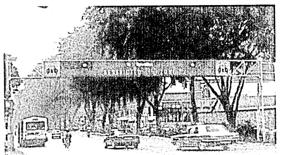
乗入れ制限地域 (RESTRICTED ZONE) 入口
