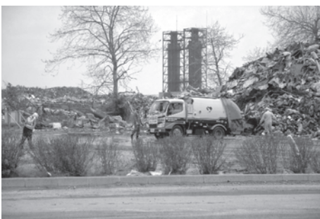
写真6 仮設置き場への搬入作業
