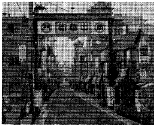
同上一步道整備後(昭和53年2月)
