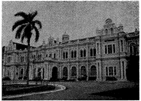
写真—3 シティホール
