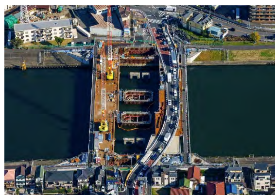
老朽橋架け替え：末吉橋（鶴見区）
