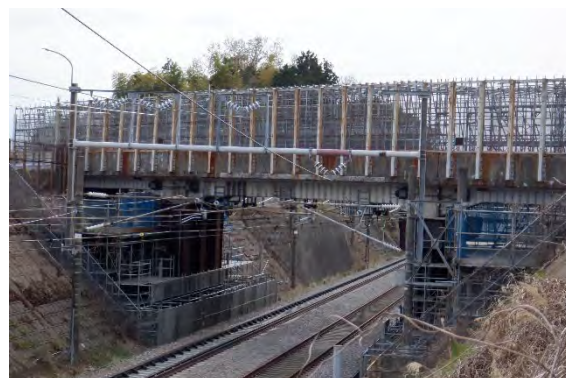
計画的な補修：第1柳明橋（泉区）
