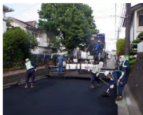
舗装修繕工事の状況(泉区)
