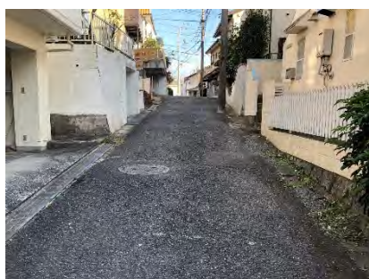
私道整備助成実施前(港北区)
