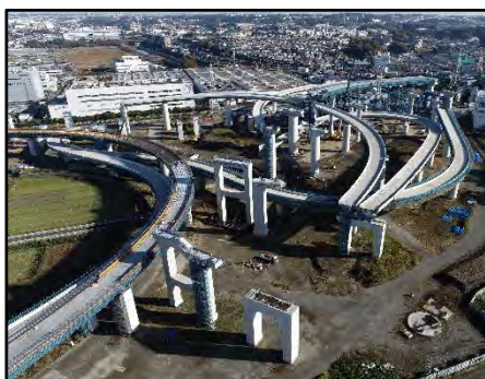
栄IC・JCT築造工事 (栄区田谷町)
