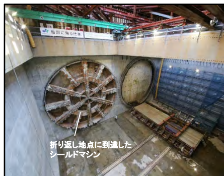
桂台トンネル工事 (栄区上郷町)
