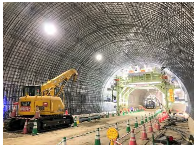
桂町トンネル工事
