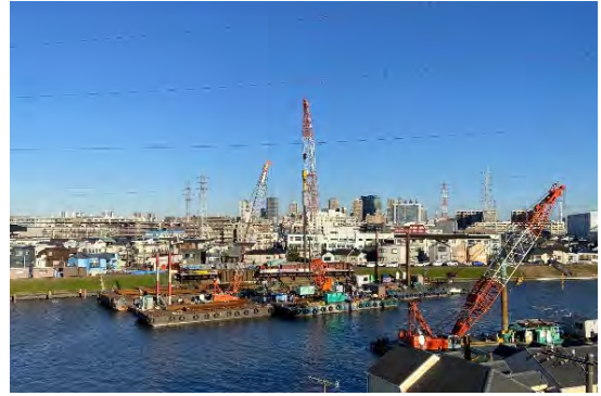
橋梁新設工事:鶴見川人道橋(鶴見区)
