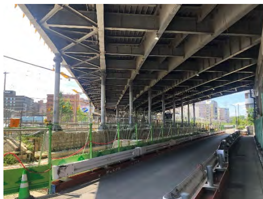
耐震補強工事:新横浜陸橋(港北区)
