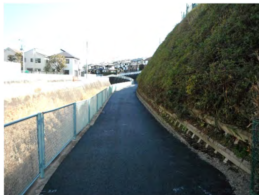
岩川沿いルートの舗装新設
