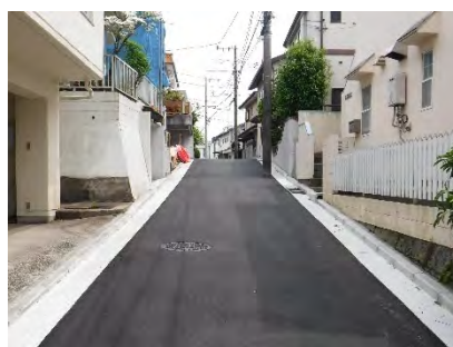
私道整備助成実施後(港北区)
