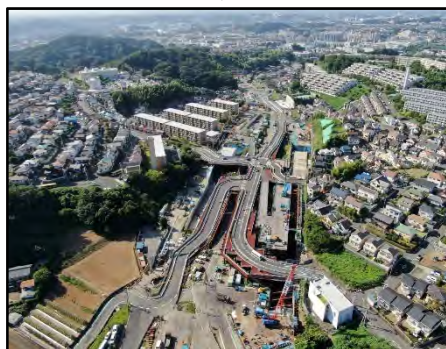
公田IC築造工事 (栄区公田町)
