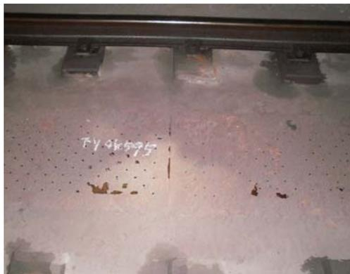
排水溝蓋(アンチスリップ鋼板)
