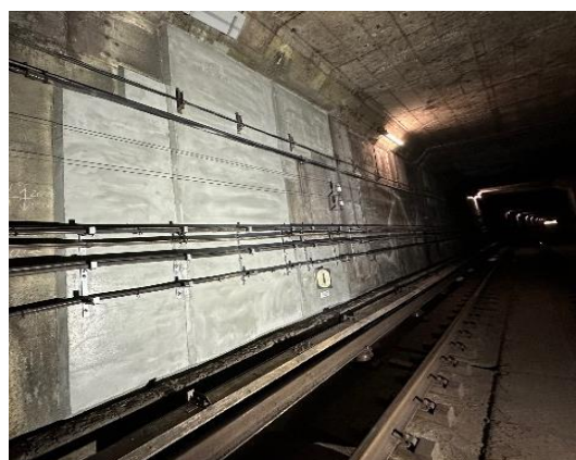
＜開削トンネルの補修＞
