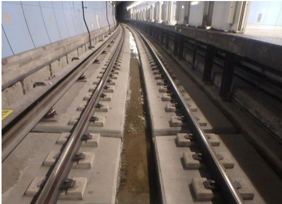
&lt;軌道改良工事施工後&gt;
