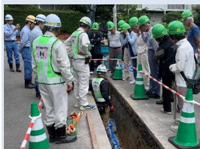
工事現場見学会
