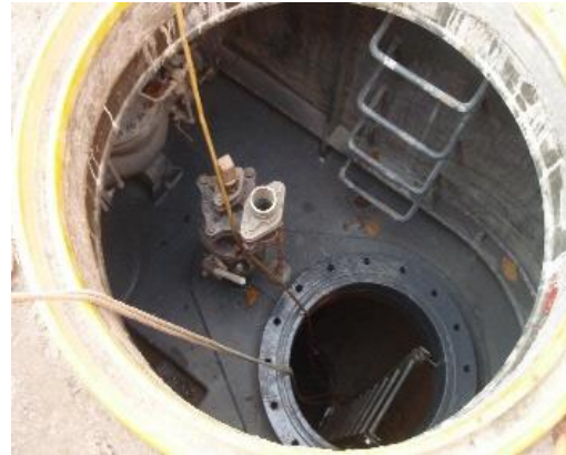
災害用地下給水タンクの点検
