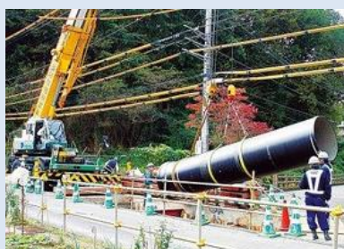
水道管の更新・耐震化工事
