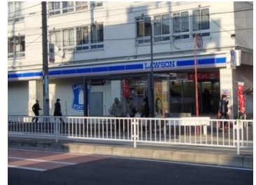
活用事例(旧南営業所の建物をコンビニエンスストアとして活用)
