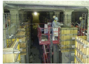
配水池の耐震化工事
