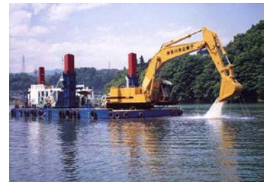
相模湖での土砂除去作業
