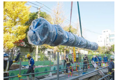
送配水管の更新工事
