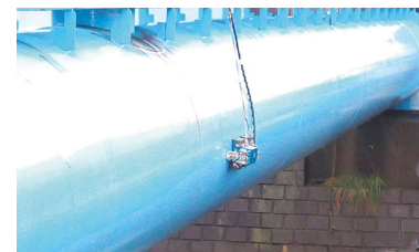
ロボットによる水管橋の点検
