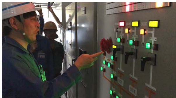
合図とともに特別高圧盤へ受電開始
