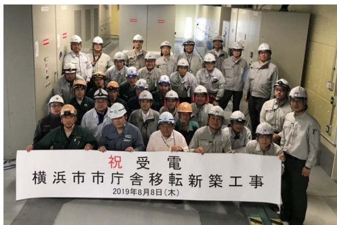
受電後の電気室にて
