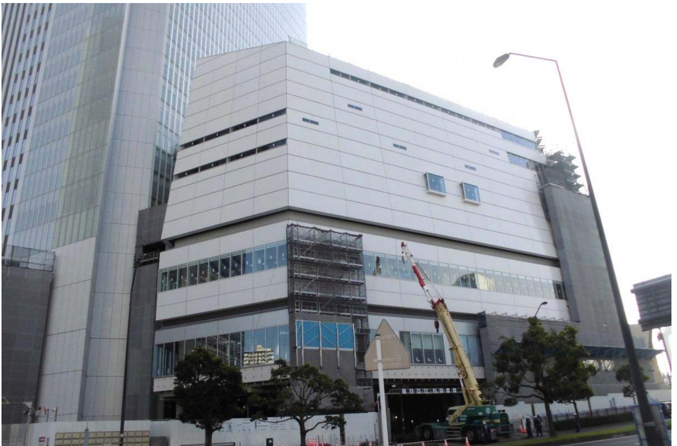
議会棟外部足場解体
