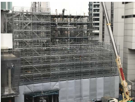
足場の組立て
