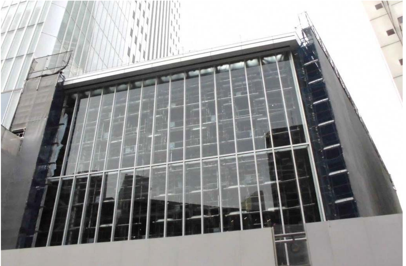
アトリウム棟外観（南面）
