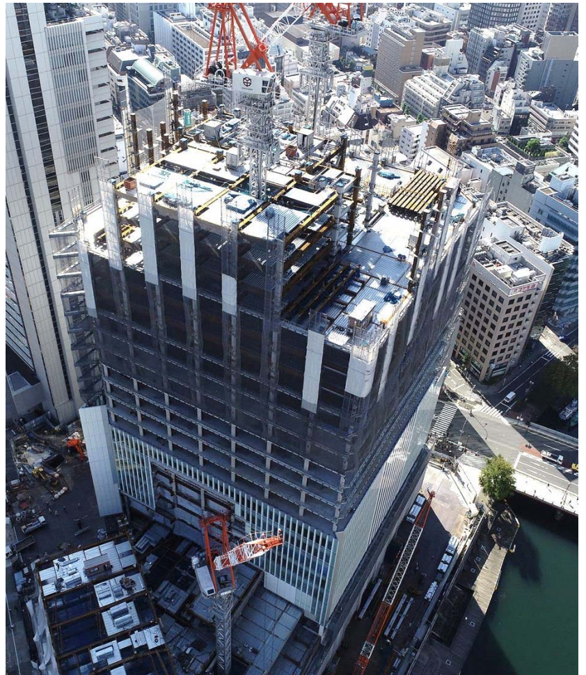
上空からの全景 (手前:議会棟、奥:行政棟)
