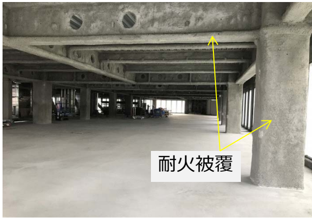
行政棟 鉄骨耐火被覆施工状況
