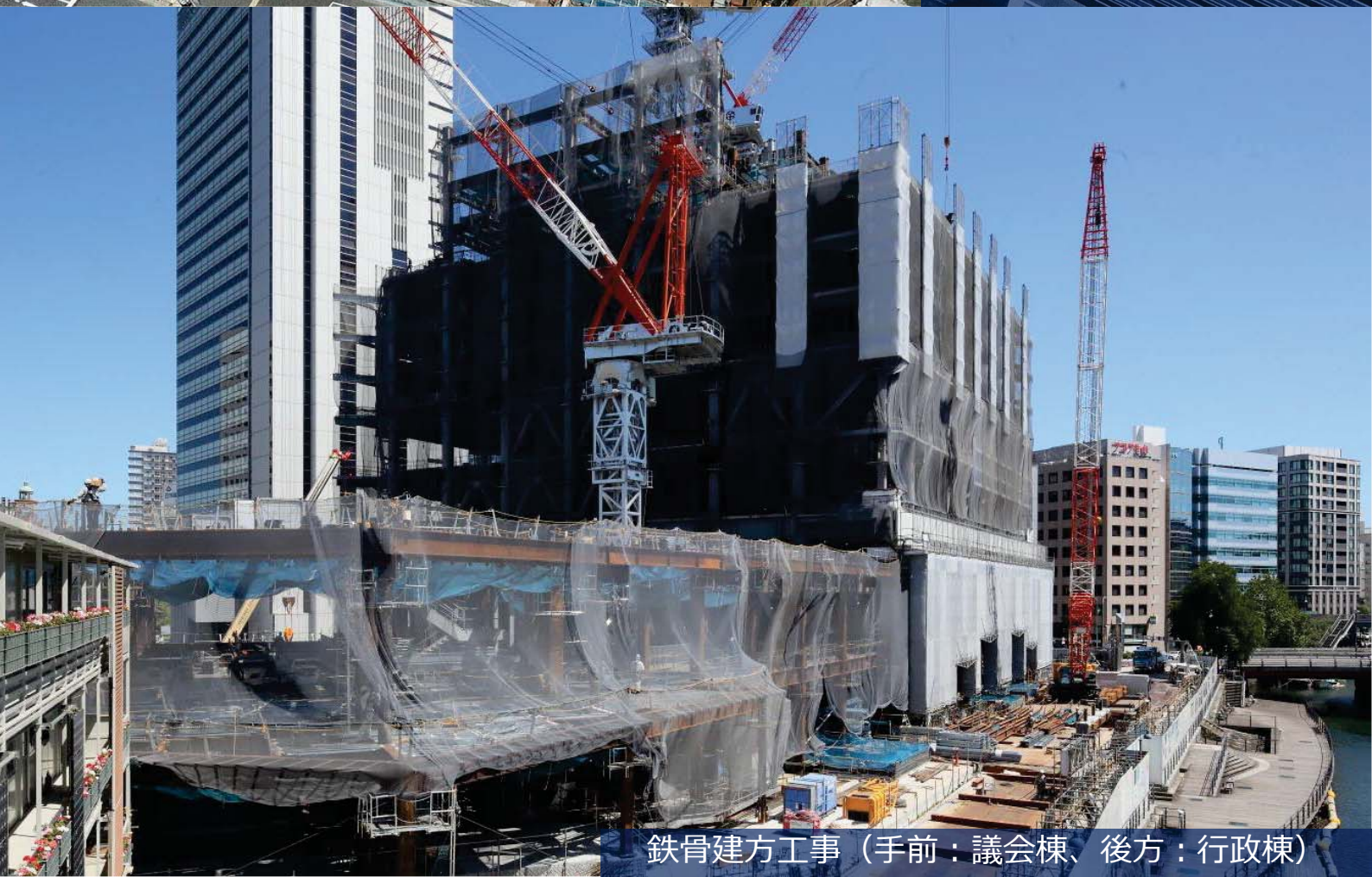
上空より建設現場を望む
