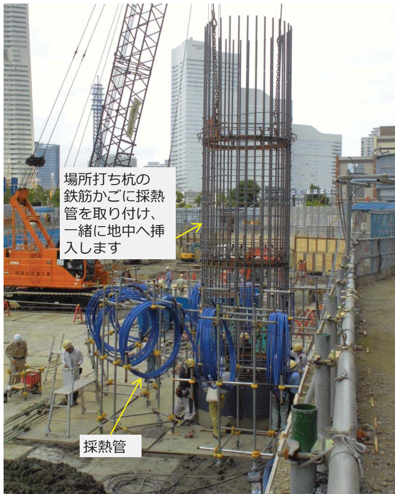
杭鉄筋に沿わせて、採熱管を取り付けている様子
