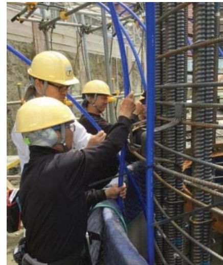
杭鉄筋に沿わせて、採熱管を取り付けている様子
