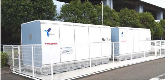
横浜市では横浜港港湾計画（平成 26 年 12 月改訂）において、エネルギー利用の効率化、低炭素化、災害時における事業継続性の確保等の港のスマート化に取り組んでいくこととしました。その取組の一環として、横浜港流通センターをモデル施設と位置付け自立型水素燃料電池システムを設置し、電力ピークカットや非常用電源の活用等の実証実験を行っています。
