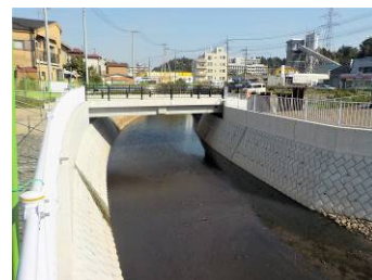
帷子川における河川改修 (旭区)
