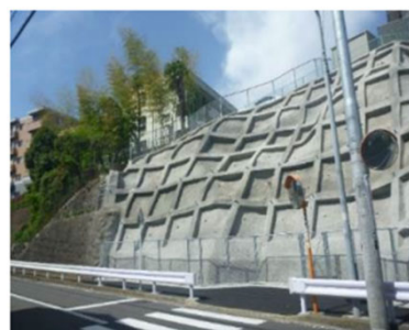
<道路がけ防災対策後>
