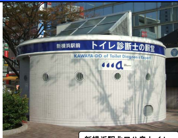
新横浜駅北口公衆トイレ
