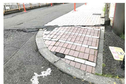
【補修する前の現場】
