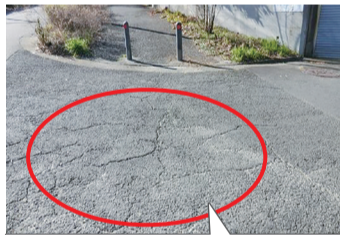
劣化した車道や歩道を補修します
