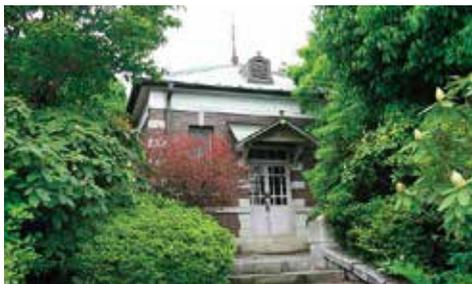
この計量室は大正3年(1914)、横浜水道第2次拡張工事に、関内、山手、本牧方面に給水配水量を計る装置を設置するために建設されました。外装には横黒・鼻黒煉瓦を用い、浄水場内に残る6基の整水室上屋の建造物と共に国の登録文化財に指定されています。
