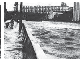
台風による浸水被害(昭和54年)
