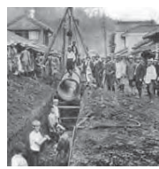
保土ヶ谷での水道管敷設の様子(大正3年頃)
