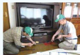
◀家具の転倒防止作業
