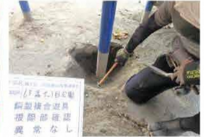
▲複合遊具の点検(精密)
