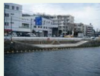
天神橋上流の荷揚場・石積み階段
