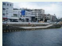
天神橋上流の荷揚場・石積み階段
