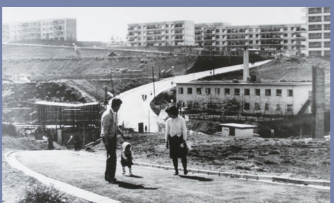
造成中の汐見台団地(昭和40年前後)
