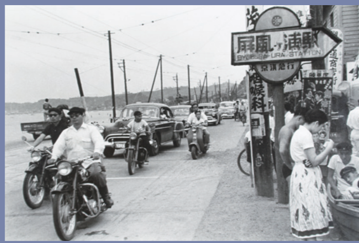
国道16号 屏風ヶ浦交差点(昭和30年頃)
