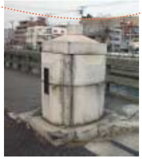
▲天神橋の「親柱」、台座が残っています。
