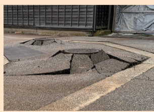
◀能登半島地震にて液状化により浮上したマンホール(石川県志賀町)
