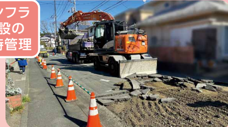
道路の設備修繕
