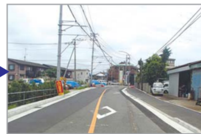
施工後(7月中旬時点)
