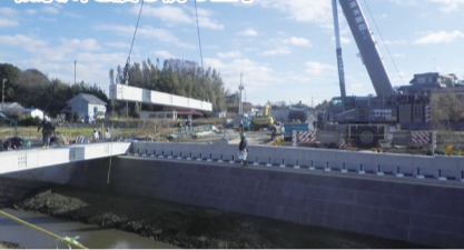
和泉川を渡る橋の工事
