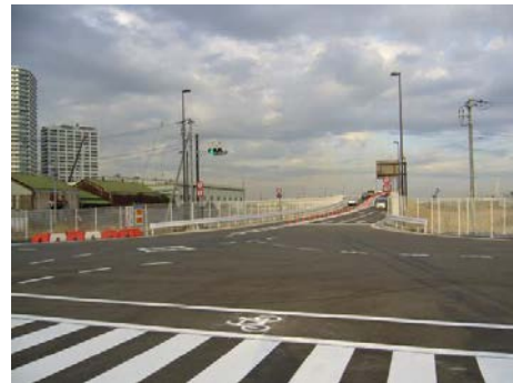
臨港幹線道路（臨港パーク～瑞穂、一部暫定供用） (平成 20(2008)年開通)
