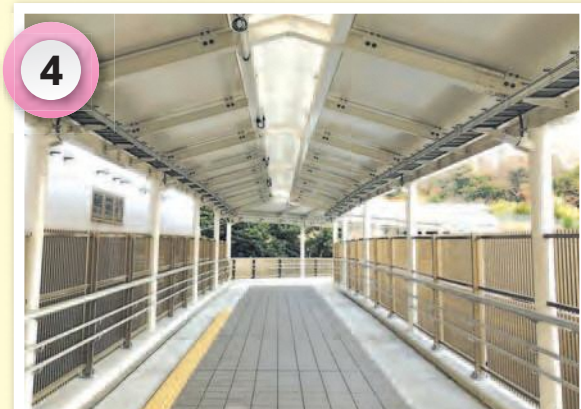
4 東西自由通路(こ線部)
