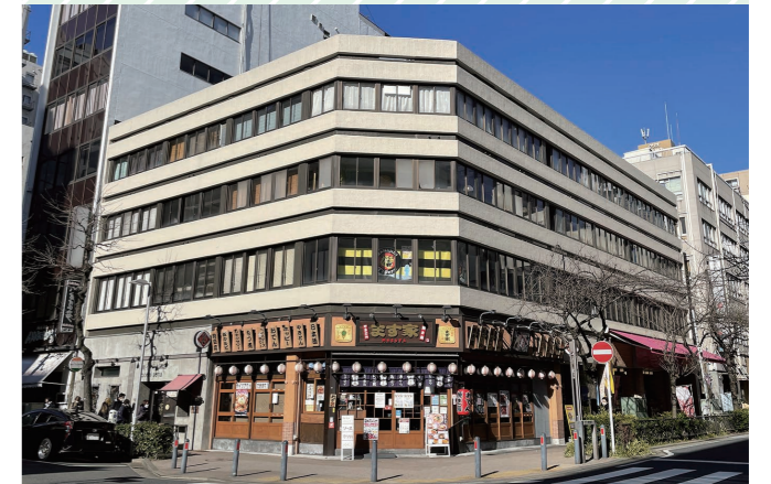
横長の窓と足元のスリット窓が水平方向を印象づけている住吉町新井ビル
