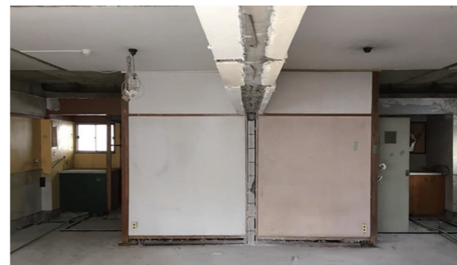
施工途中 壁を撤去して2室を一体化
