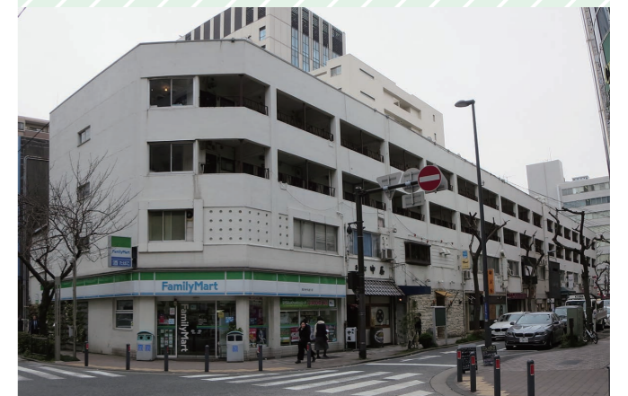
今も現役で稼働中の県公社が手がけた第1号の防火帯建築 井三ビル
