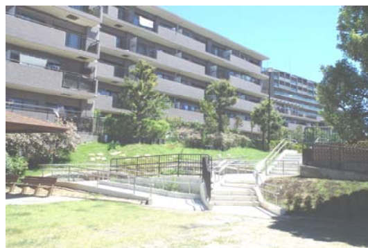
（写真）緑区東本郷六丁目第二公園（施工後）
