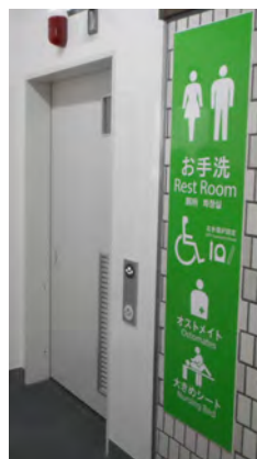
多機能トイレの出入口ドア表示 ： 内部に配置されている設備をピク トグラムで表示しています。
