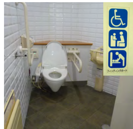
広めのトイレの表示 ：車いす使用者や 子ども連れで利用できる広めトイレで あることがわかるよう、扉にピクトグ ラムで表示しています。
