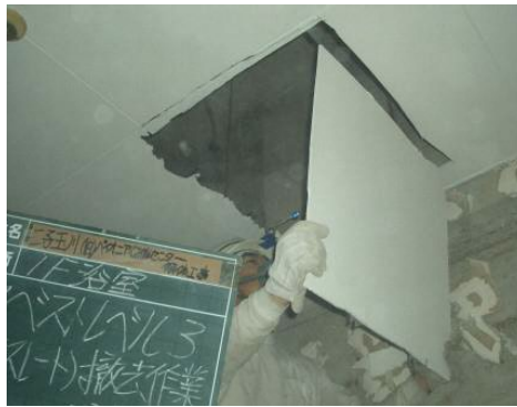
②天井ボード撤去
