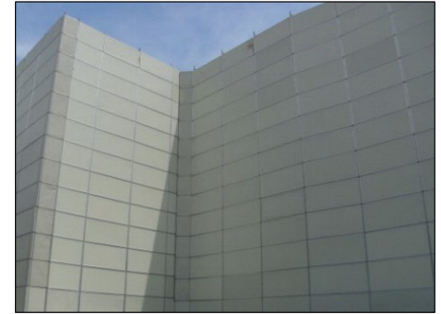
養生足場の例
