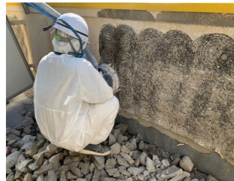
③超高压水洗工法 による除去
