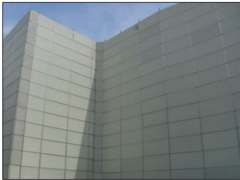
養生足場 + 防音パネルの例
