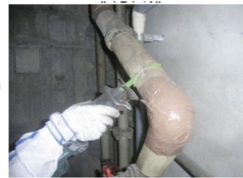
④石綿含有部の切断
