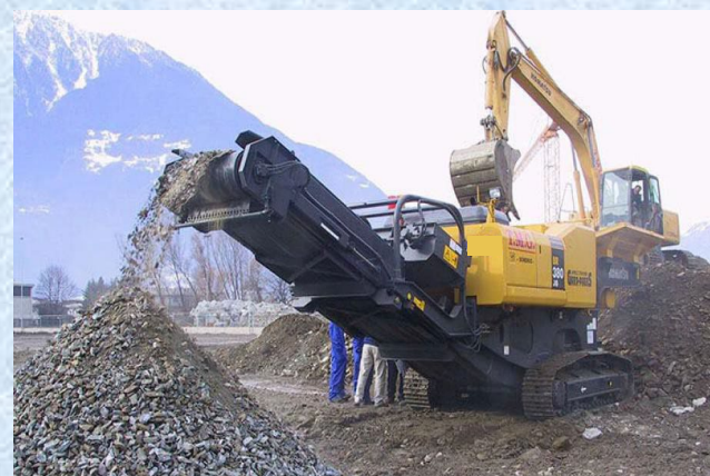
②現場で自走式破砕機により コンクリート塊を破砕加工
