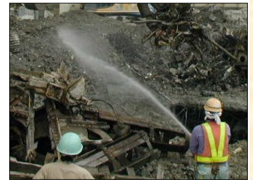
散水養生の例
