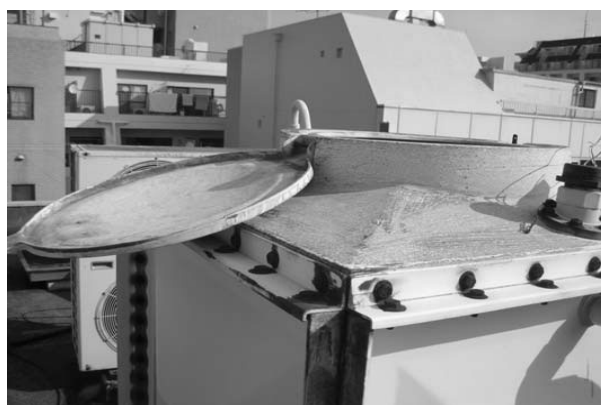
写真2 高置水槽の蓋の開放
