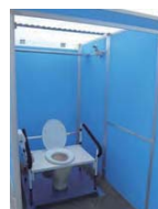
下水道直結式仮設トイレ
