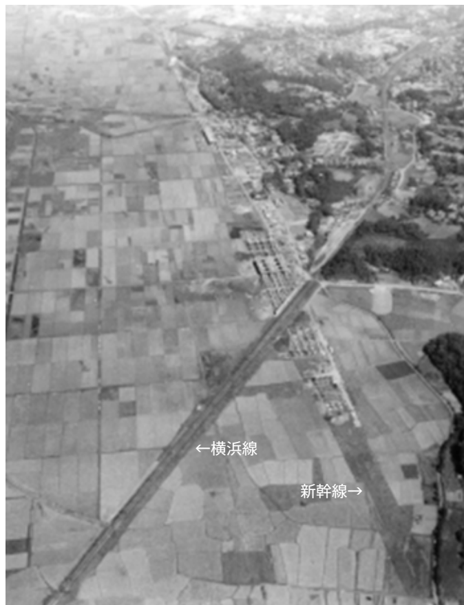
新幹線工事中(1962年頃)
