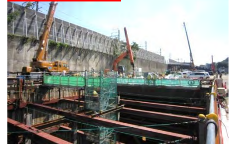
⑤羽沢トンネル
