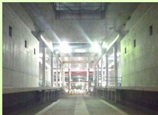
工事の状況(ホーム階)
