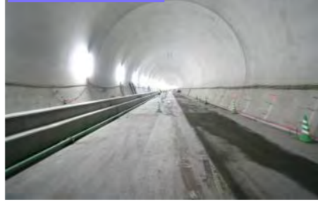
②西谷トンネル
