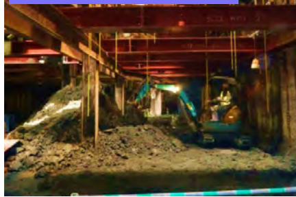
①西谷駅付近(開削トンネル部)
