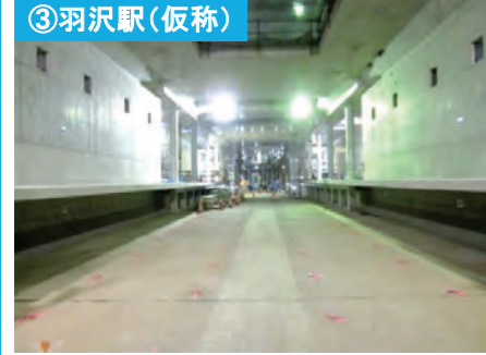
③羽沢駅(仮称) 駅舎の躯体工事が完了し、今後は地上部の駅舎工事や軌道工事・電気工事等の設備工事を実施します。
