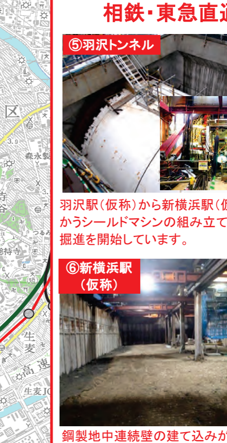
⑥新横浜駅(仮称) 鋼製地中連続壁の建て込みが完了し、環状2号線の下で掘削しています。
