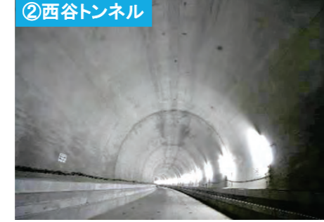
②西谷トンネル トンネル本体の土木工事が完了し、今後は軌道工事や電気工事等の設備工事を実施します。
