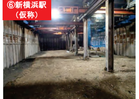
⑥新横浜駅(仮称) 鋼製地中連続壁の建て込みが完了し、環状2号線の下で掘削しています。
