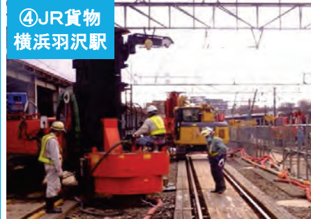
④JR貨物 横浜羽沢駅 駅構内において、開削トンネルを構築するための土留杭の工事を実施しています。
