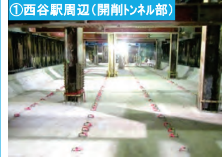
①西谷駅周辺(開削トンネル部) 相鉄本線の線路下の掘削が完了し、箱型トンネルを構築しています。
