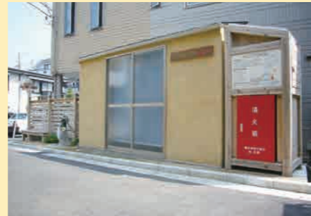
地下貯水槽と手押しポンプ
