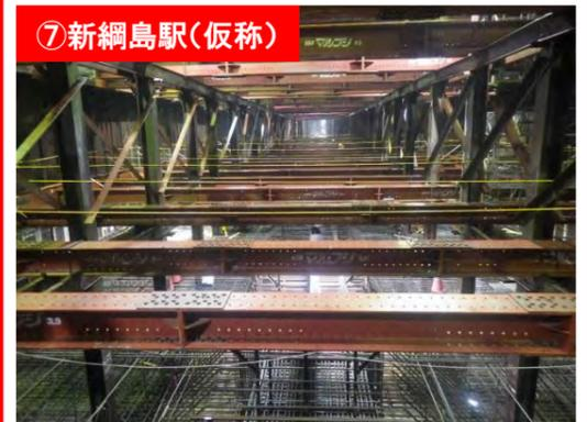
地下部での掘削が完了し、最も下の層の「下床版」から順次上の層へ鉄筋コンクリートの構築を進めています。
