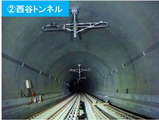
信号および通信ケーブルの敷設が完了しました。引き続き電気設備の設置工事を進めています。
