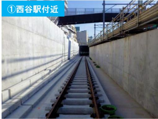
西谷駅付近から西谷トンネルに至る区間では、レールの敷設が概ね完了しました。引き続き電気工事を進めます。
