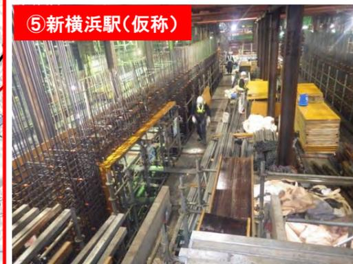
環状2号線の直下で地下駅の工事を行っています。写真は地下3階の鉄筋組立ての様子です。
