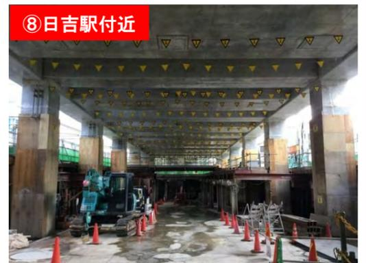
高架橋下に相鉄・東急直通線の構造物を新設するため、東横線の既設高架橋の受け替えを進めています。
