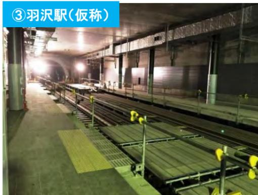
ホーム部はコンクリート構造物やレールの敷設工事が完了し、設備の工事を行っています。
