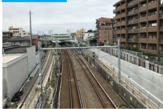
①西谷駅付近
