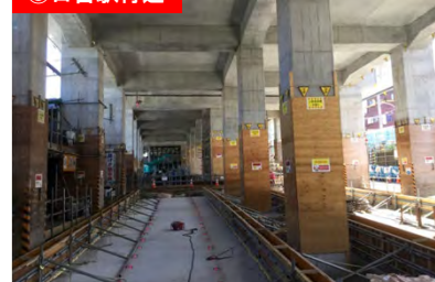
⑧日吉駅付近
