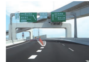
⑤ 横浜港北JCTの分岐部
