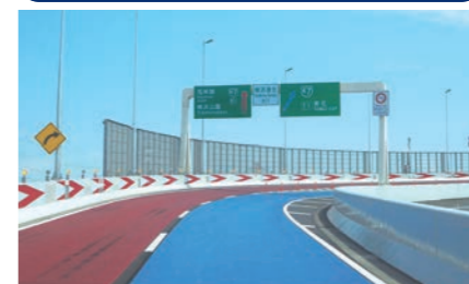
⑧ 横浜北西線と横浜北線の分岐
